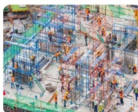
GENERALNE WYKONAWSTWO W ZAKRESIE BUDOWY I FIT-OUT
